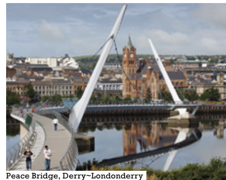
Peace Bridge, Derry~Londonderry
