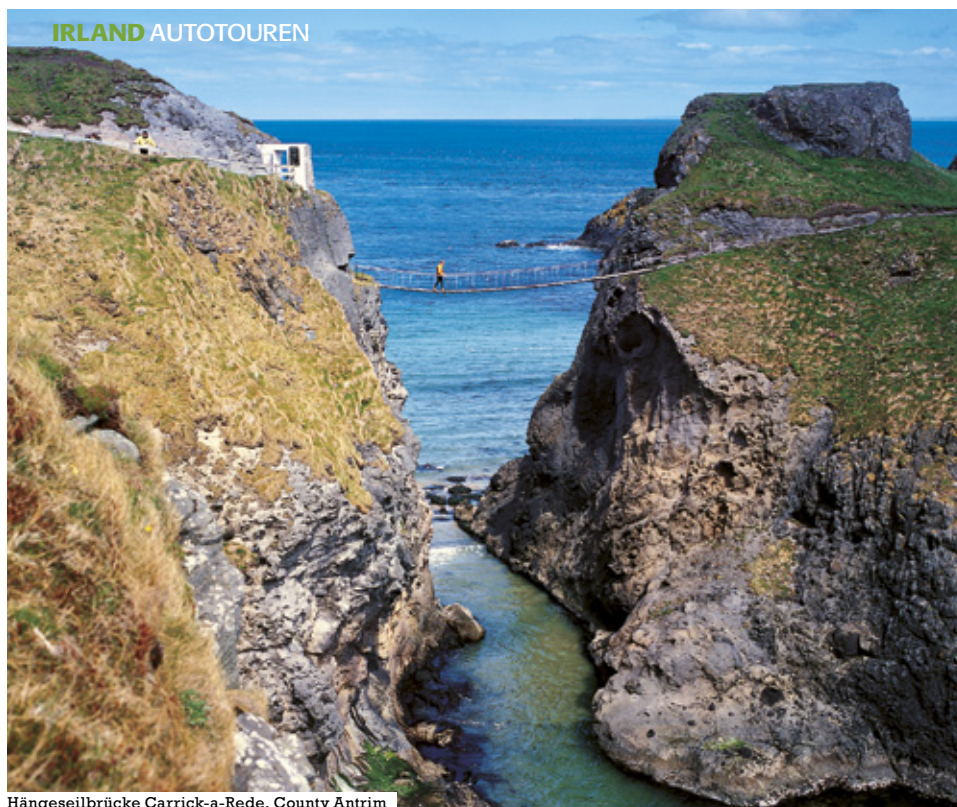
Hängeseilbrücke Carrick-a-Rede, County Antrim
