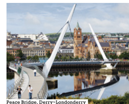
Peace Bridge, Derry~Londonderry
