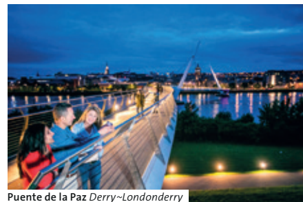
Puente de la Paz Derry~Londonderry
